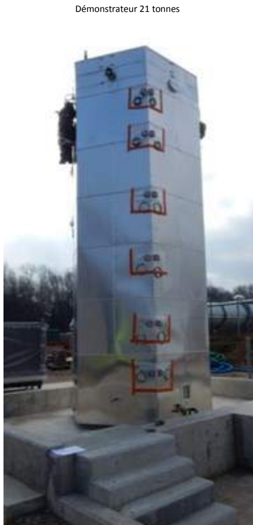
Stockage de chaleur par matériau à changement de phase
